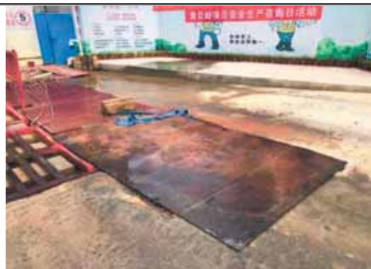
主出入口沉砂池
