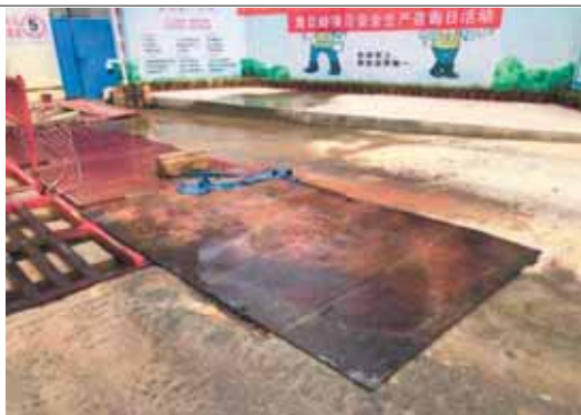
主出入口沉砂池
