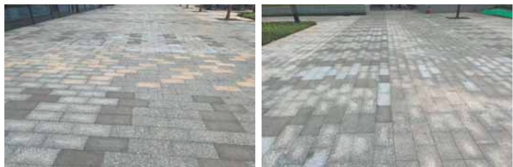
地砖铺装措施
