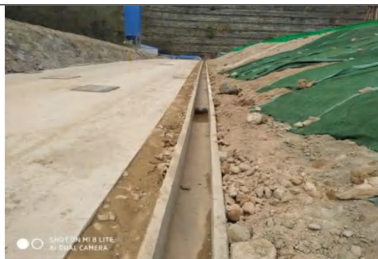
场地内西部临时道路边沟（1）
