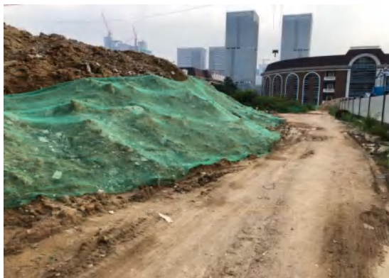
现场临时覆盖（1）
