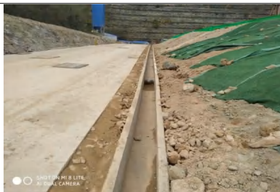
场地内西部临时道路边沟（1）
