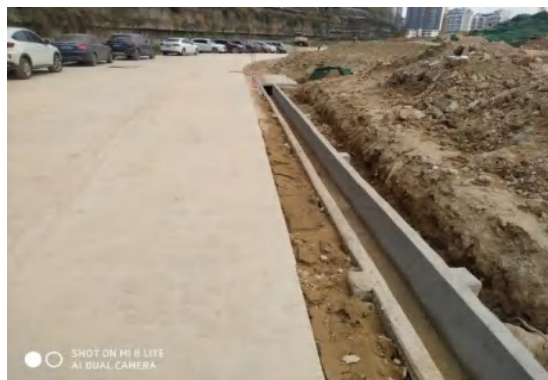
场地内北部临时道路边沟（3）
