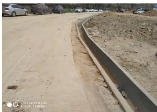
场地内北部临时道路边沟（1）
