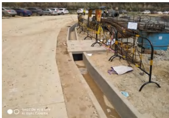
沿边沟一侧设置沉砂池（1）
