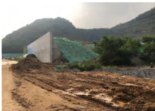
现场临时覆盖（4）
