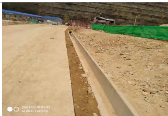
场地内西部临时道路边沟（2）
