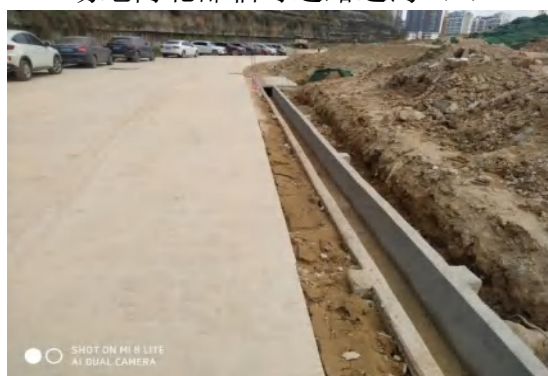
场地内北部临时道路边沟（3）
