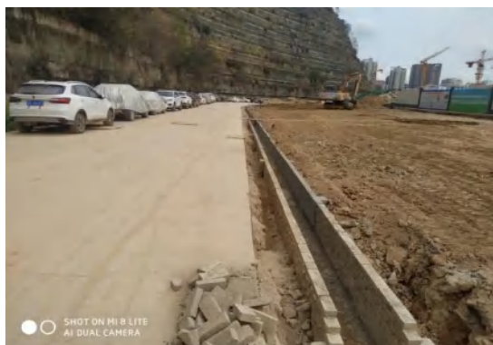
场地内北部临时道路边沟（2）
