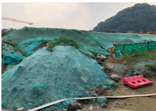
现场临时覆盖（3）
