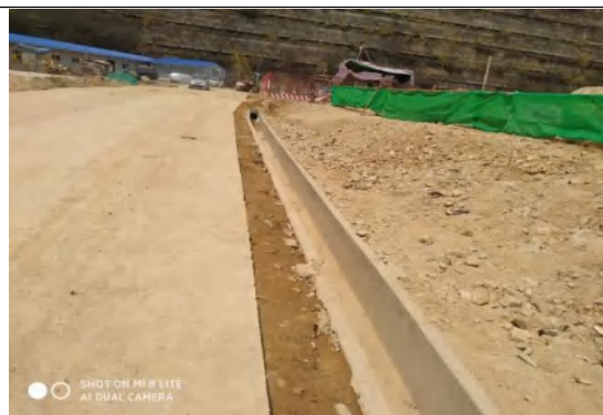
场地内西部临时道路边沟（2）
