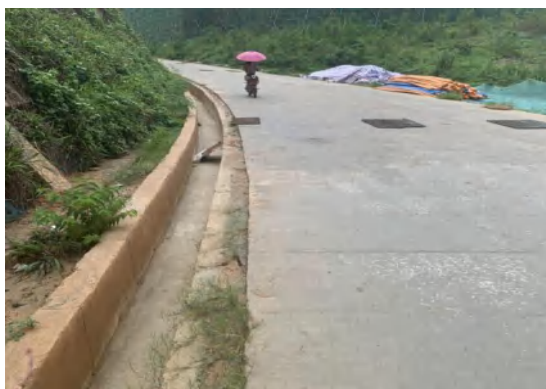
道路旁排水沟（1）
