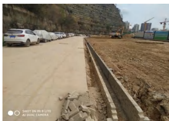
场地内北部临时道路边沟（2）
