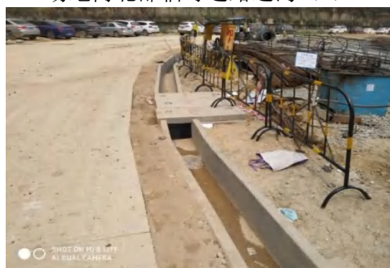
沿边沟一侧设置沉砂池（1）
