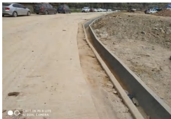
场地内北部临时道路边沟（1）
