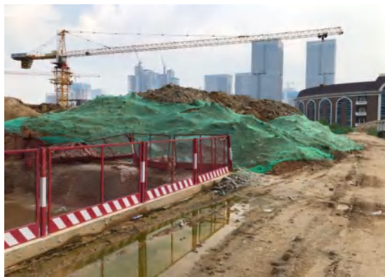
现场临时覆盖（2）
